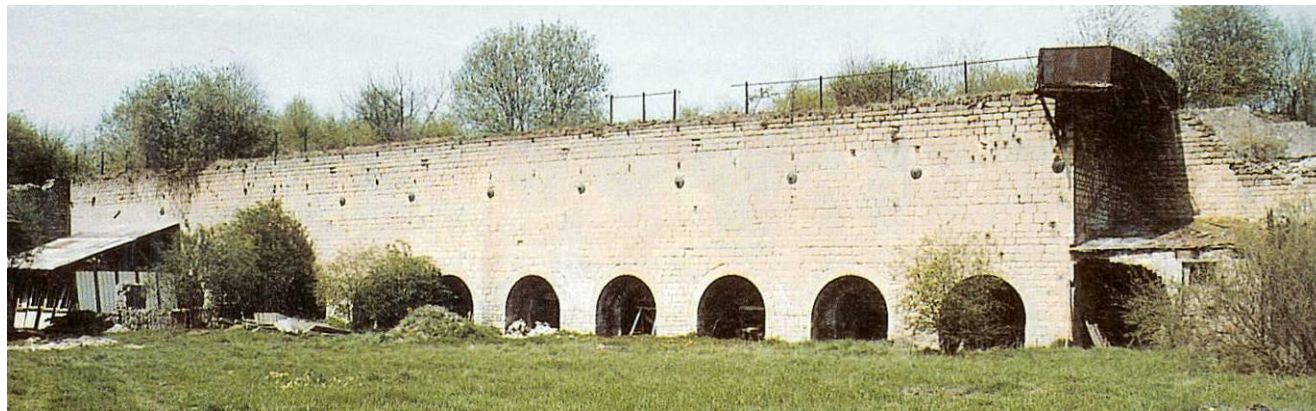
Batterie de 12 fours à chaux
